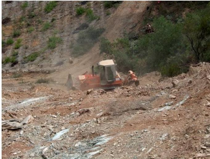
**Lâmina bulldozer e ripper
