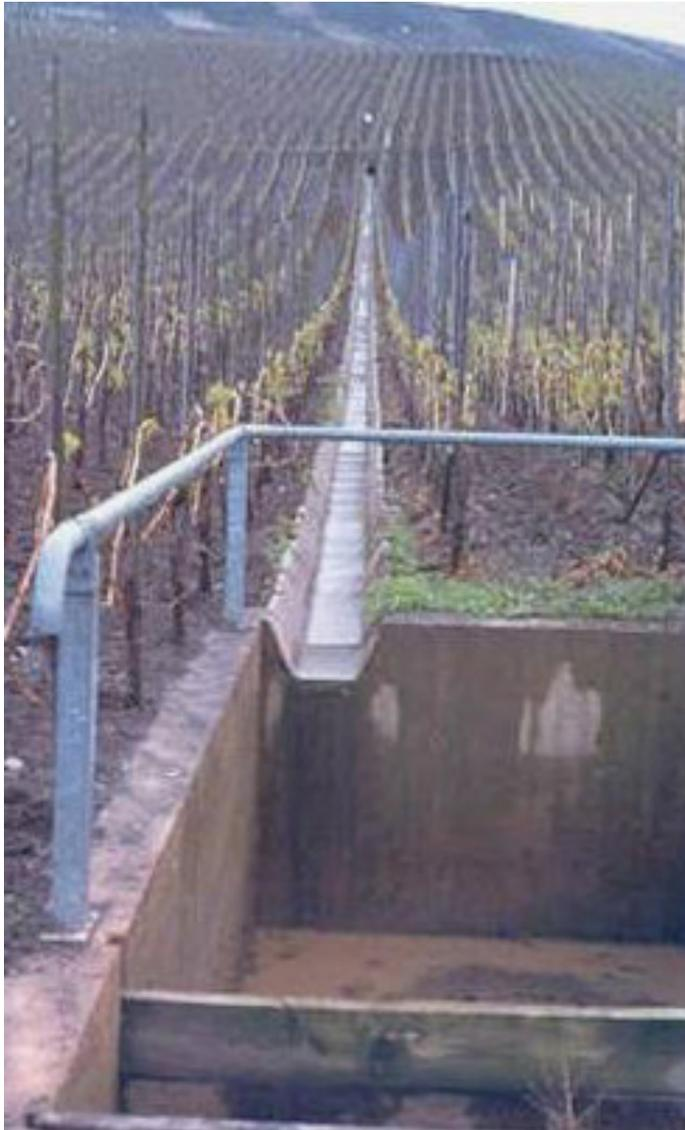
Canal de escoamento e bacia de recepção das águas
