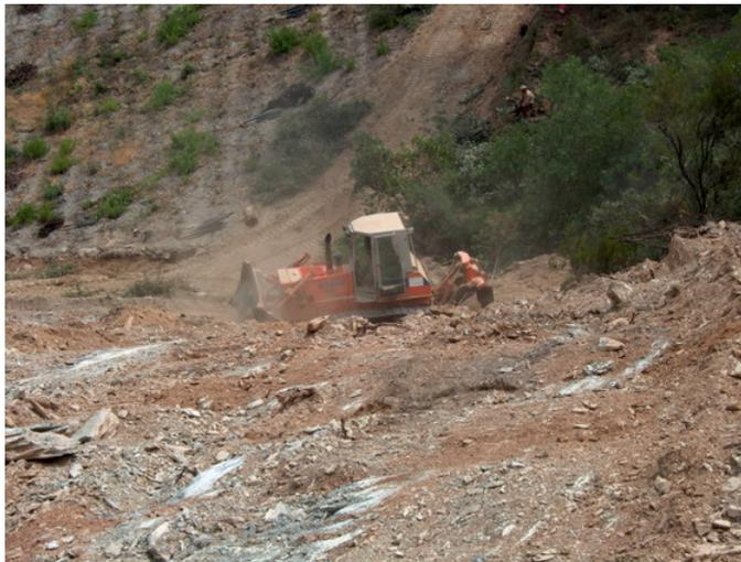
**Lâmina bulldozer e ripper
