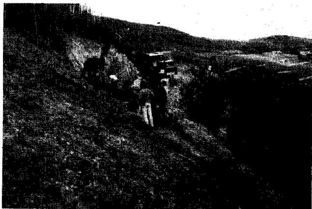
Fotog. 7.6 — Piesport: construção de estrada (por escavação/aterro e do respectivo muro de suporte.
