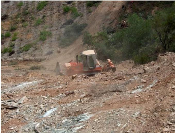
**Lâmina bulldozer e ripper
